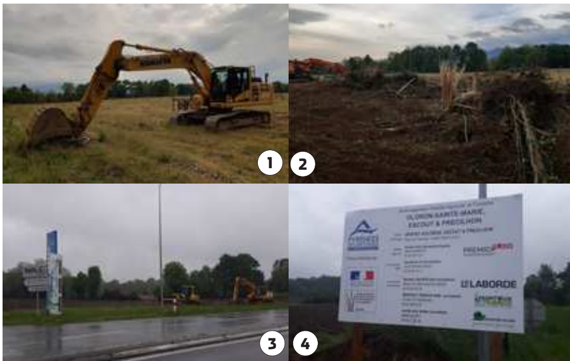
L'entrée en action des pelleteuses est dénoncée par les collectifs écologistes d'Oloron (1 et 2). Les engins de chantier sont visibles en bordure de la RN134 (3) où un panneau détaille les parties engagées dans le remembrement (4). © BENOÎT ROUZAUD ET DR
